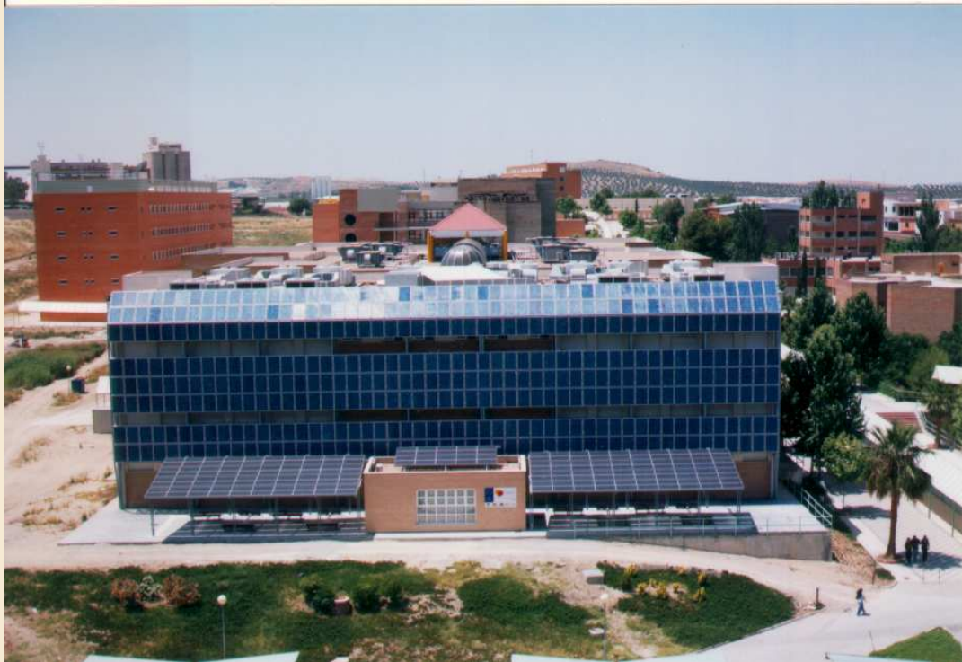
Figura 3. Integración arquitectónica en la fachada de un edificio en el proyecto "Univer" (40 kWp)
