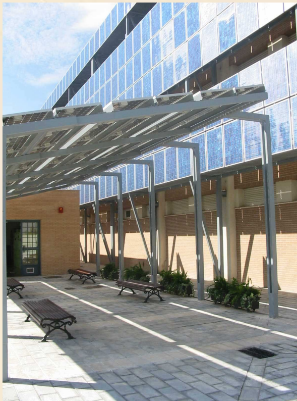
Figura 2. Estructura Pérgola como solución arquitectónica en la integración fotovoltaica en el proyecto "Univer" (20 kWp)
