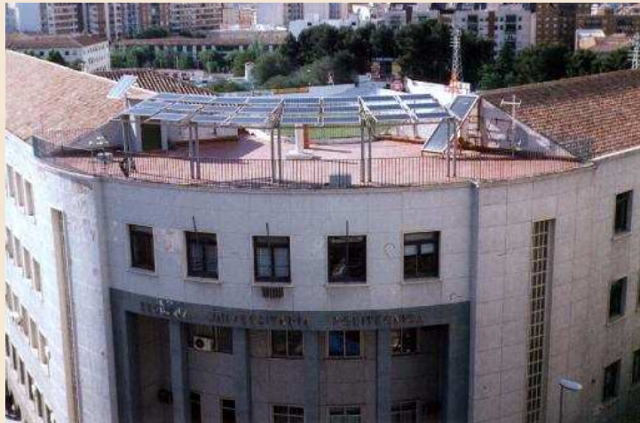
Figura 6. Integración arquitectónica fotovoltaica. El proyecto "Pérgola Fotovoltaica"
