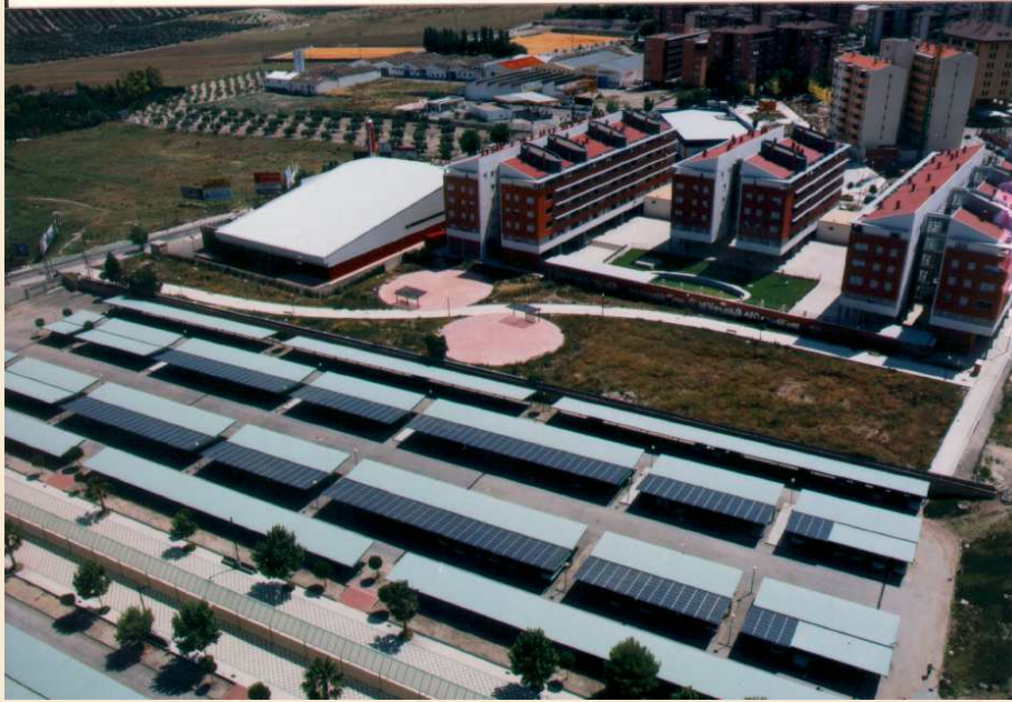
Figura 1. Cubiertas en el aparcamiento como solución arquitectónica en la integración fotovoltaica en el proyecto "Univer" (140 kWp)
